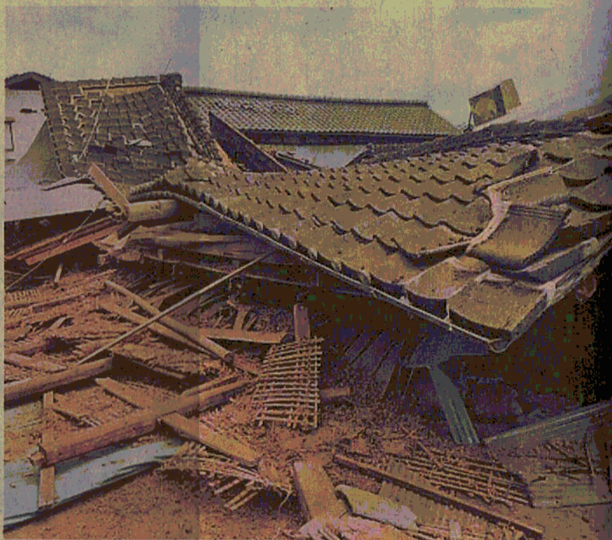
本震後に倒壊した車庫兼物置。4月16日午後0時56分、熊本県益城町（泉川病院提供）
