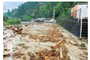
土砂流木で寸断された道
