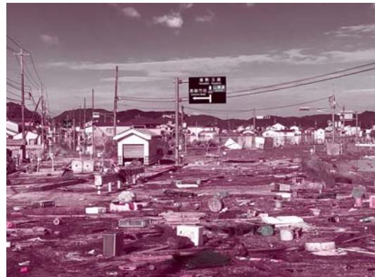
図1 西日本豪雨災害による被害（倉敷市真備町）
